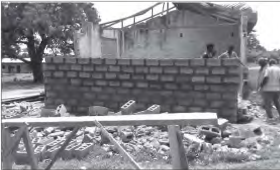
Les travaux de réhabilitation des salles de classe endommagées sont en cours. (PHOTOS : DR)
