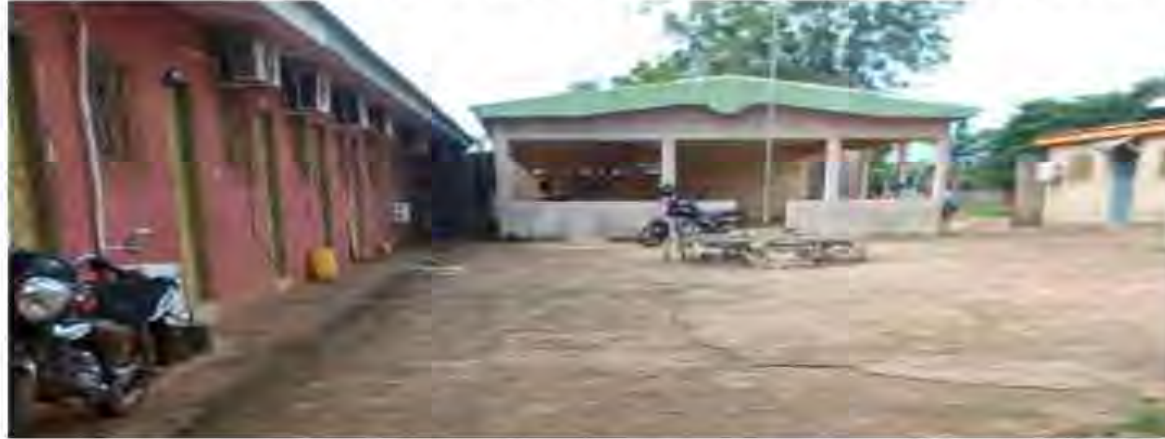
Dans la ville de Sinfra, l'EPP Sinfra 1, vide
